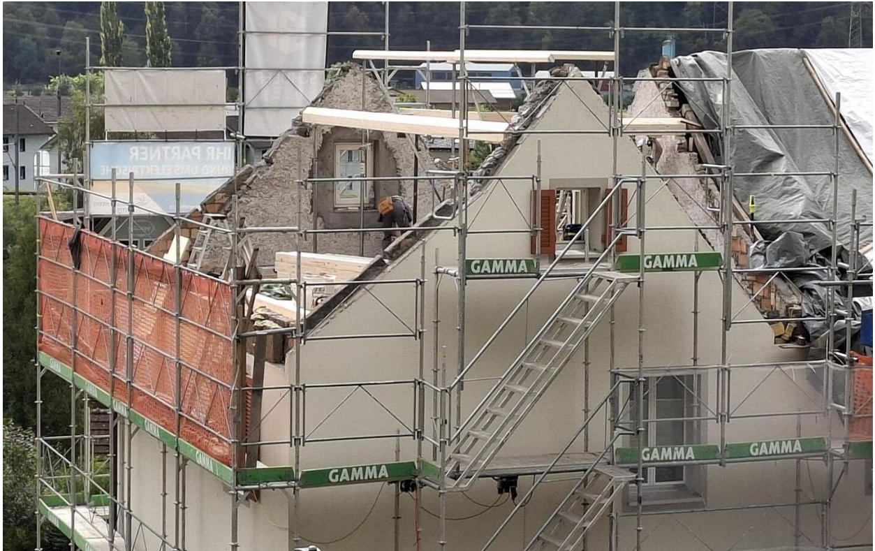
Kompletter Abbruch von Dach und Holzwerk bis auf den alten Estrichboden.
