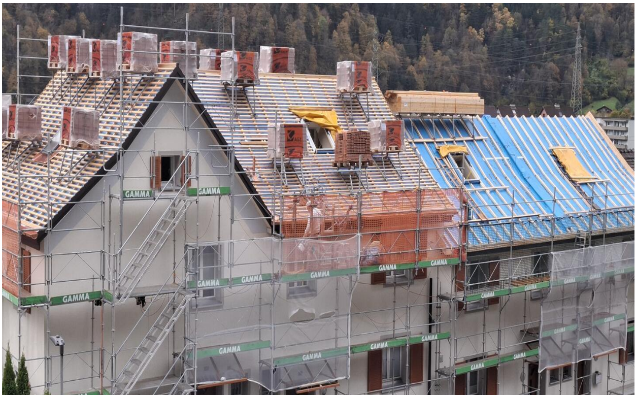
Neuaufbau Tragwerk, Firsterhöhung um ca. 40 cm, Neueindeckung, Innenausbau.
