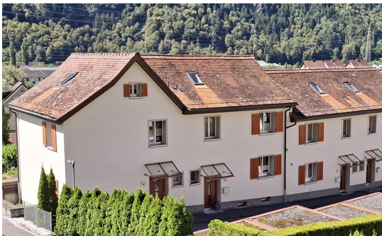
Vor Baubeginn, Dachziegel aus Gründerzeit mit eingetragener Jahreszahl 1908.
