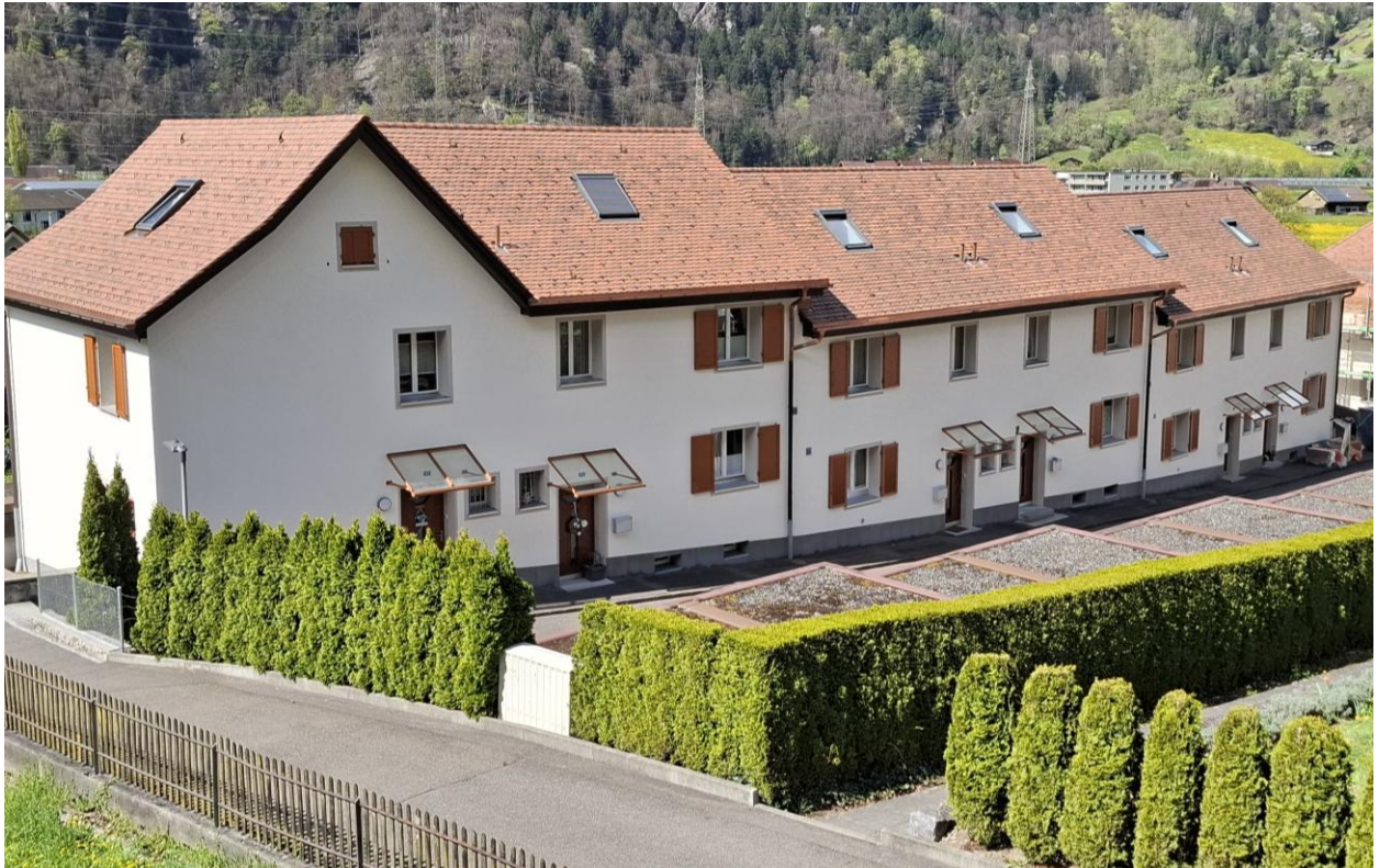
Im neuen Glanz: neues Dach, Streichen der Fassaden, Auffrischen der Jalousien.
